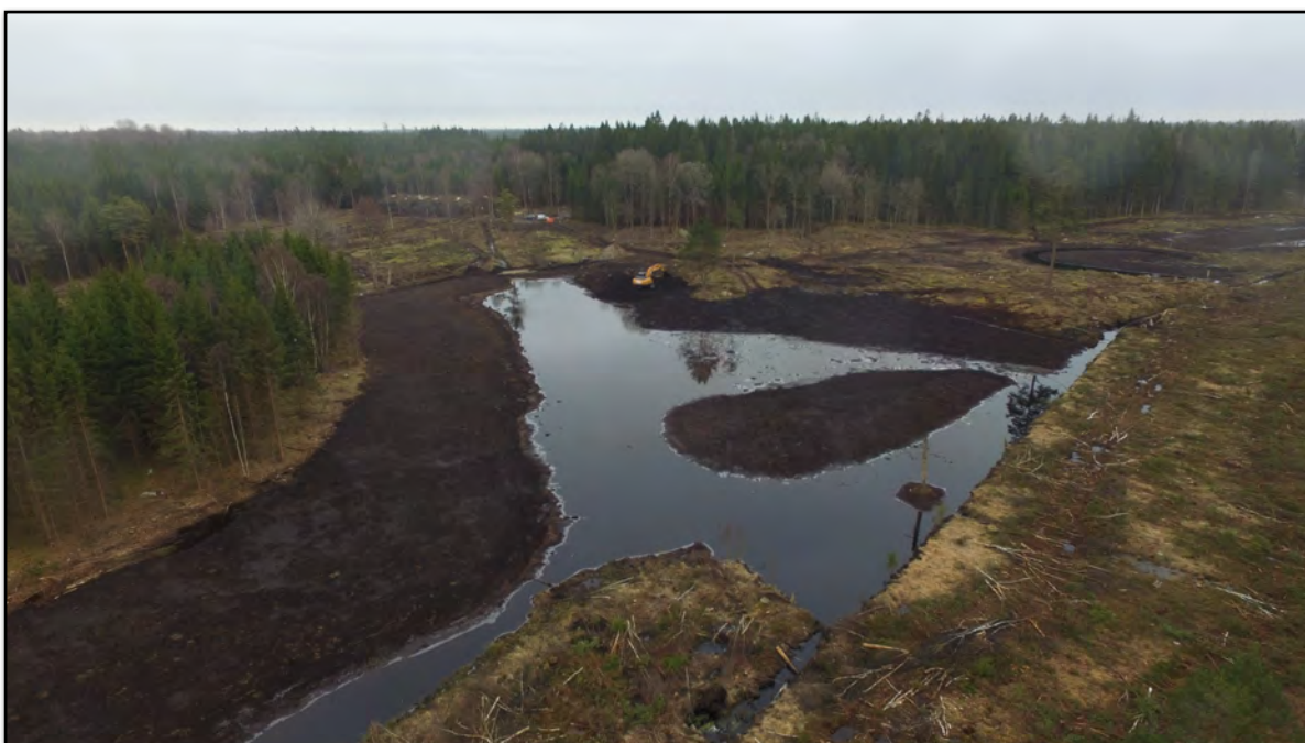
Figur 42. Våtmarken vid Hövidstorp är färdiggrävd och börjar fyllas med vatten. Foto: Daniel Bergman.
