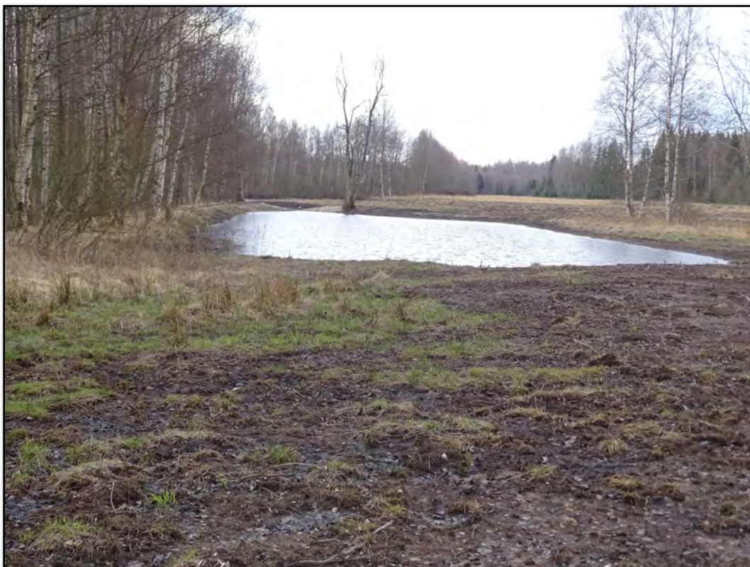
Figur 44. En anlagd sedimentationsfälla vid Grimsboda fångar partiklar och jord samt fördröjer vattnets transport vid höga flöden. Foto: Agne Andersson.
