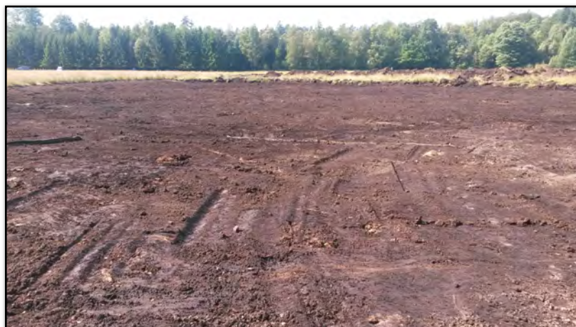
Figur 46. En anlagd svämplan vid Grimsboda, i Ekeshultsåns avrinningsområde. En grund och obeskuggad våtmark är optimal för nedbrytning av järn-humus komplexen eftersom UV-ljuset är en viktig faktor för nedbrytningen. Efter att våtmarken anlagts återvände tofsvipan som förekom i området i slutet av 1960-talet. Foto: Agne Andersson.
