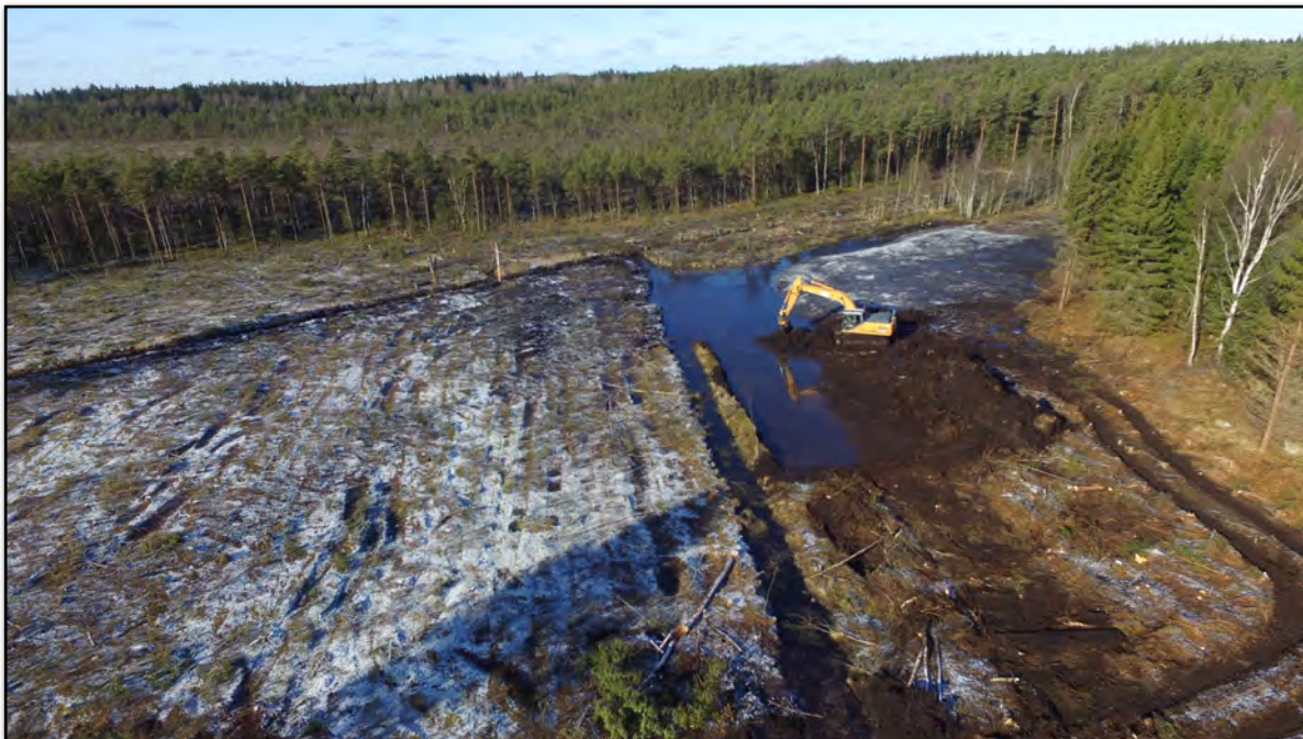
Figur 41. Flygbild över det inledande arbetet på den anlagda våtmarken vid Hövidstorp. Foto: Daniel Bergman.
