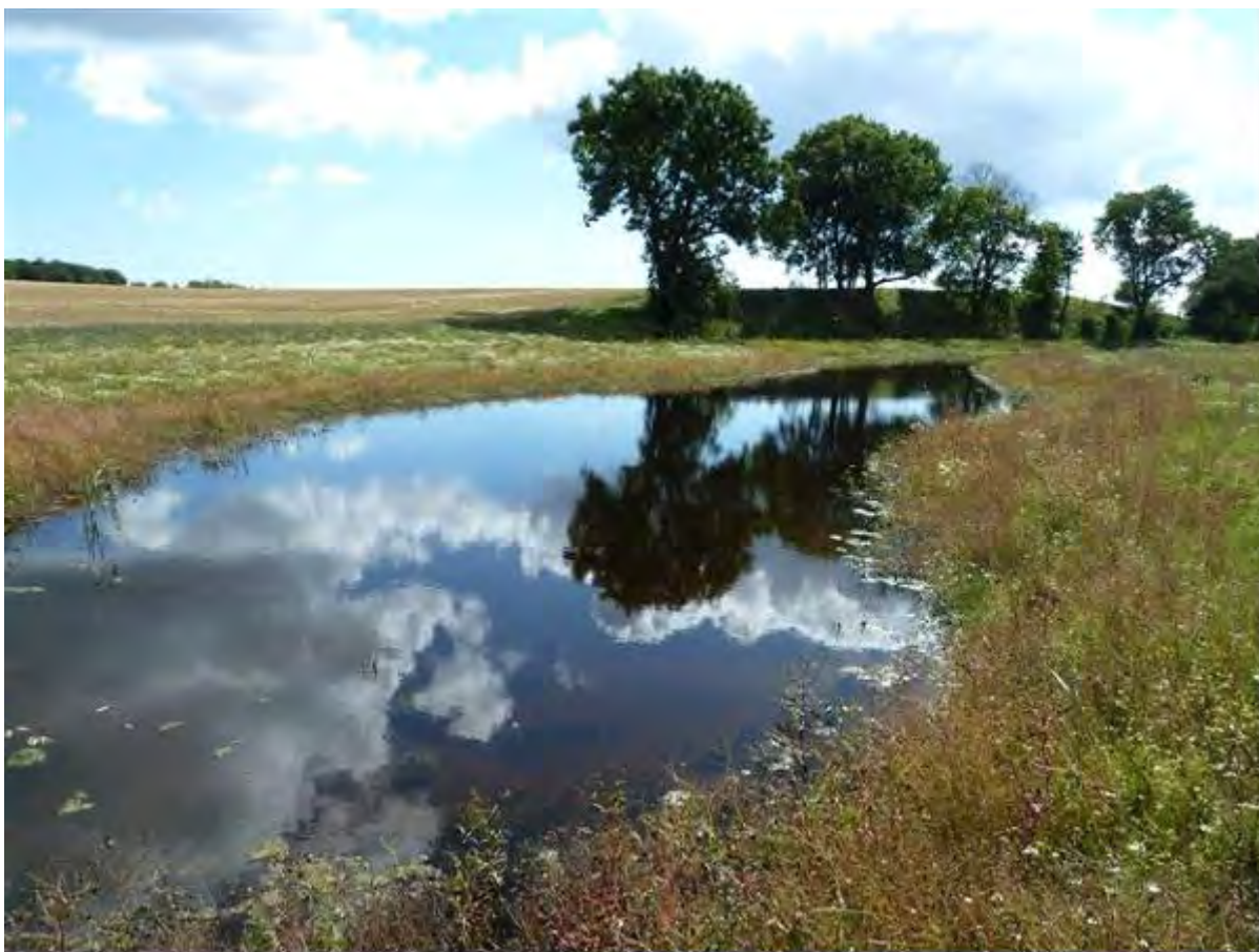
Figur 2.4 Exempel på anlagd sedimentfälla i Tullstorpsån i Trelleborgs kommun
