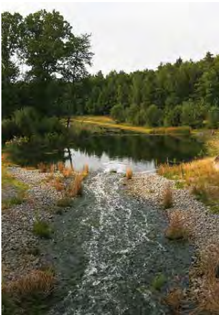
Har släpps vattnet från reningsverket ut i första dammen. I forsen syresätts vattnet.
