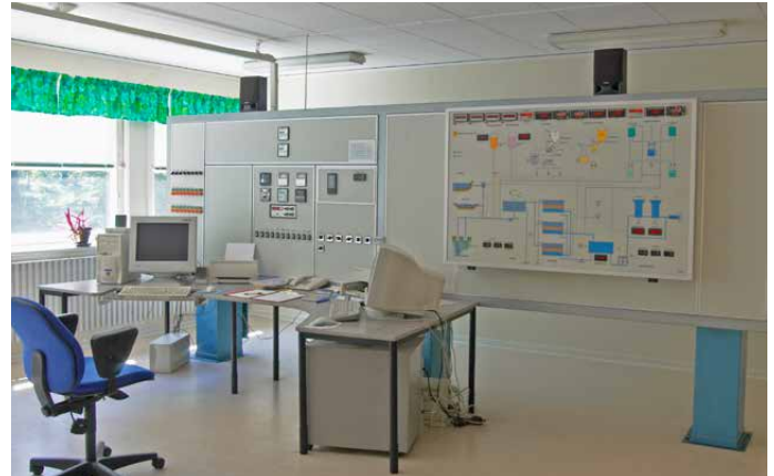
Från kontrollrummet styrs och övervakas hela vattenproduktionen.
