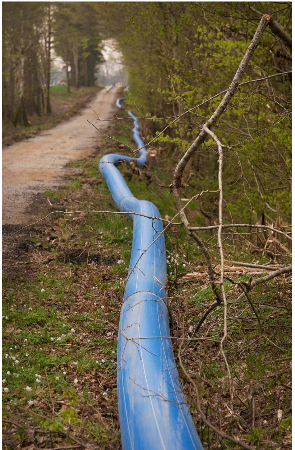
Pipelinen från Bromölla via Näsум har grävts ner längs den gamla banvallen.
