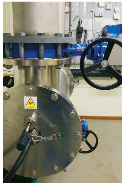
I den här tuben belyses vattnet med UV-ljus innan det skickas vidare till vattentornen.
