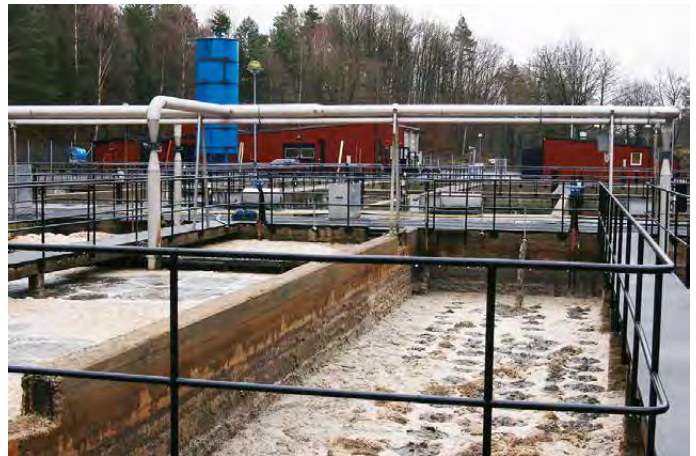
Här tillförs luft till bakterierna i slammet.
